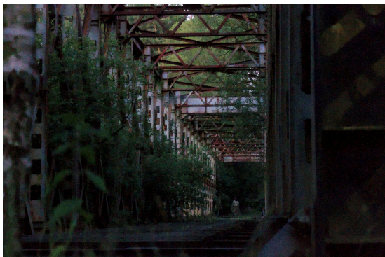
Železniční most v Plouznici (2019)
